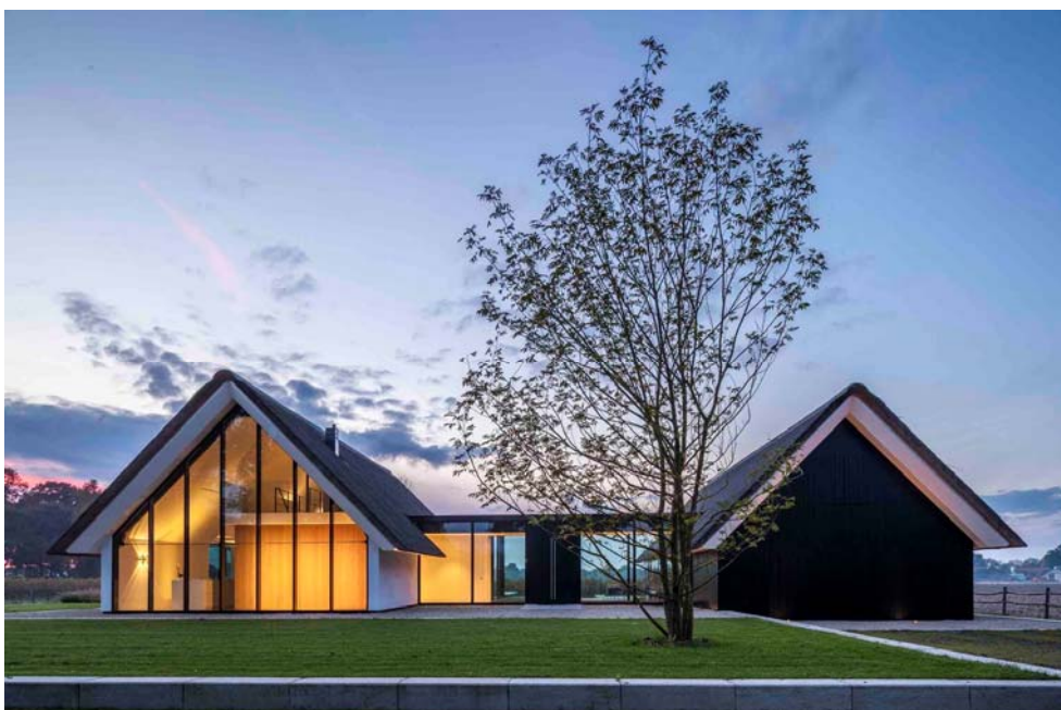
Külföldi példa. Modern épület hagyományos formavilággal, az udvar felé modern anyaghasználattal
