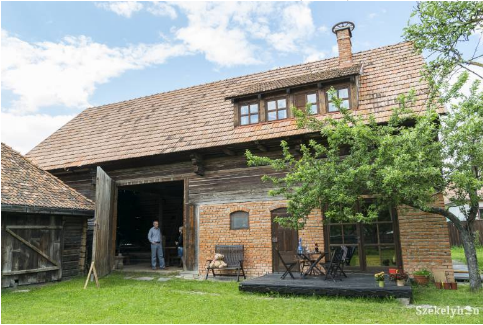
Hagyományos keresztcsűr átépítve lakó funkcióval, modern részletekkel
